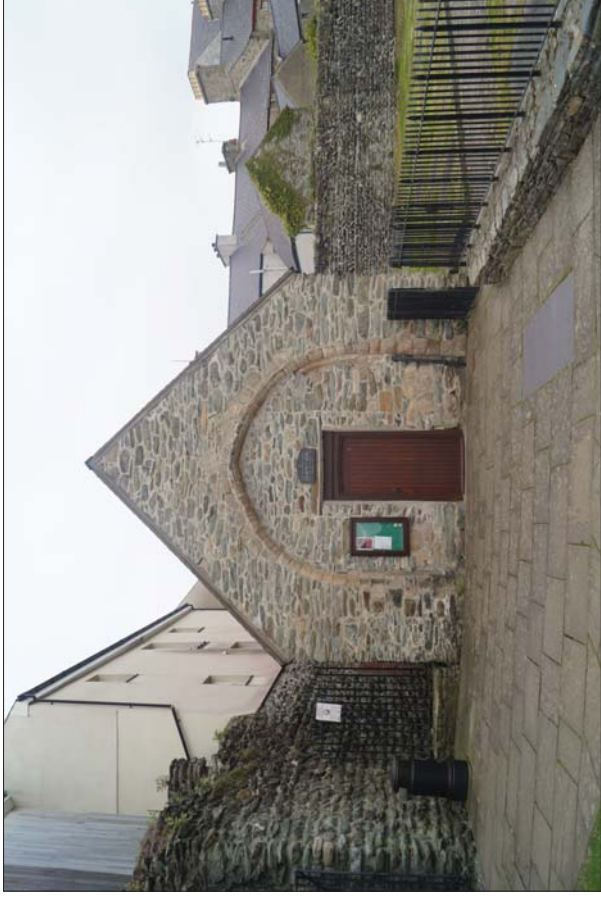
Plate 15. Eglwys y Bedd East Facing Gable
